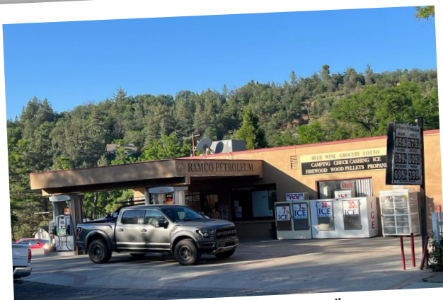
El abastecimiento de combustible se da en esta pequeña gasolinera.
